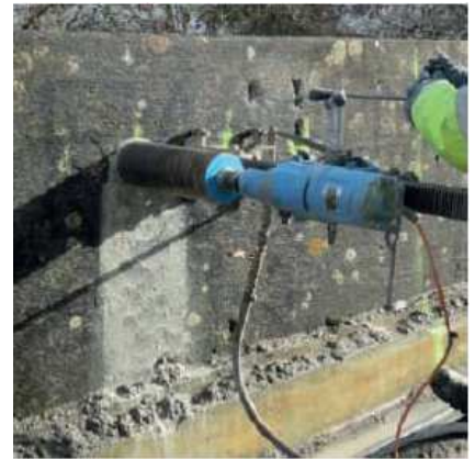
Carotteuse avec abattage à l'humide
