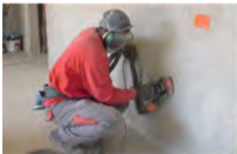
Ponçage béton
