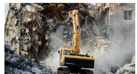
Démolition Avec engins
