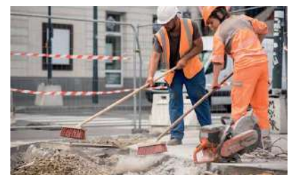
Nettoyage de chantier Au balai, à la soufflette...
