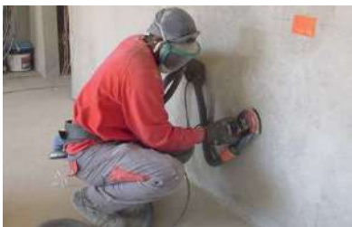
Travaux de maçonnerie Ponçage de béton...
