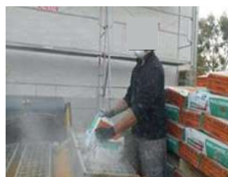
Ravaleur, maçon Grattage d'enduit, malaxage...
