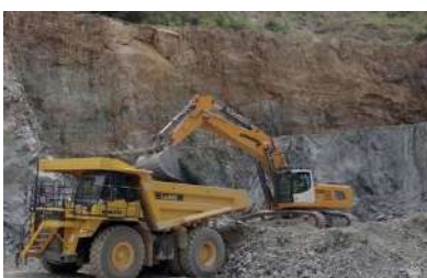
Carrières Travaux d'extraction, broyage, concassage...
