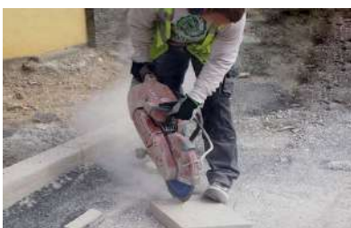
Travaux publics Sciage de bordures, terrassement ...
