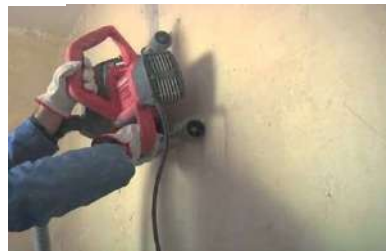
Électricité Saignée, rainurage dans mur en béton
