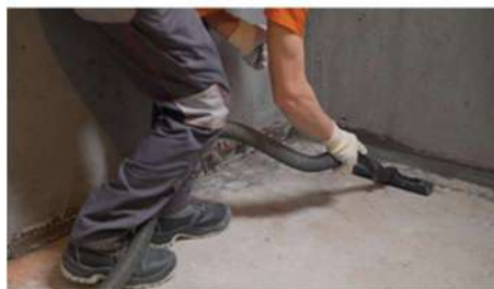
Nettoyage de chantier
