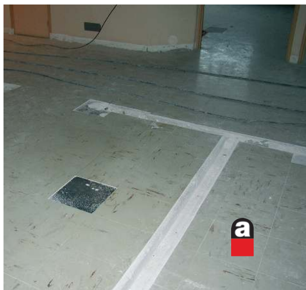
Dans les dalles vinyle-amiante ▶
